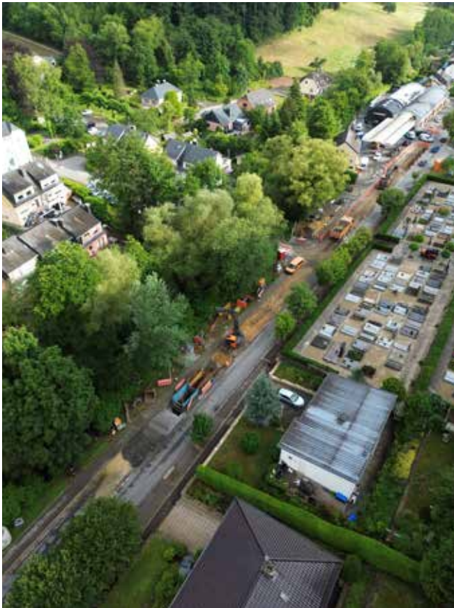
Bléck op en Ofschnëtt vum Chantier Vue d'un tronçon du chantier
