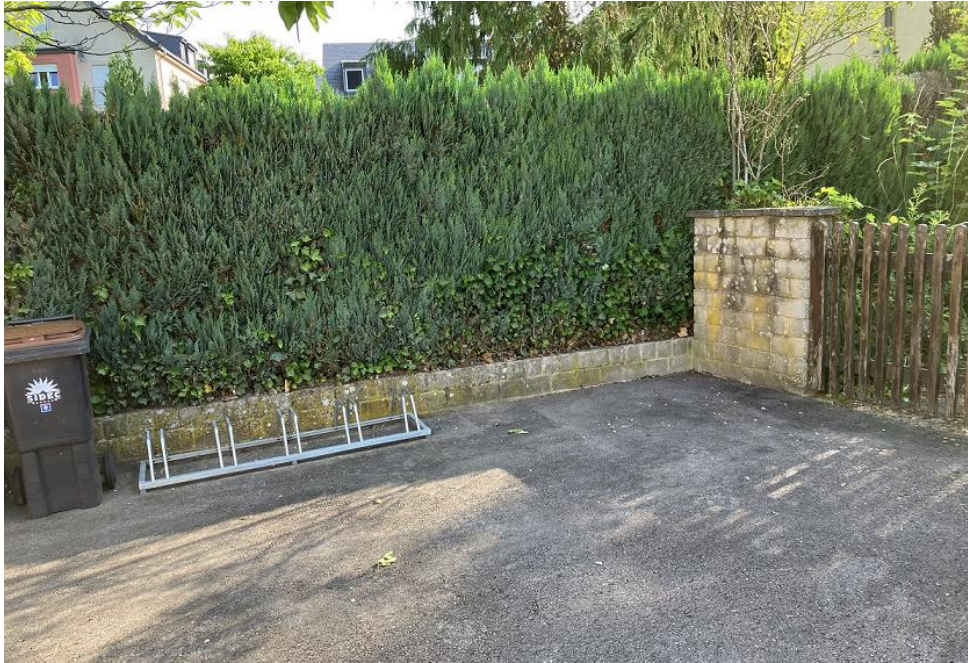
Abbildung 3: Blick auf die nördliche Mauer
