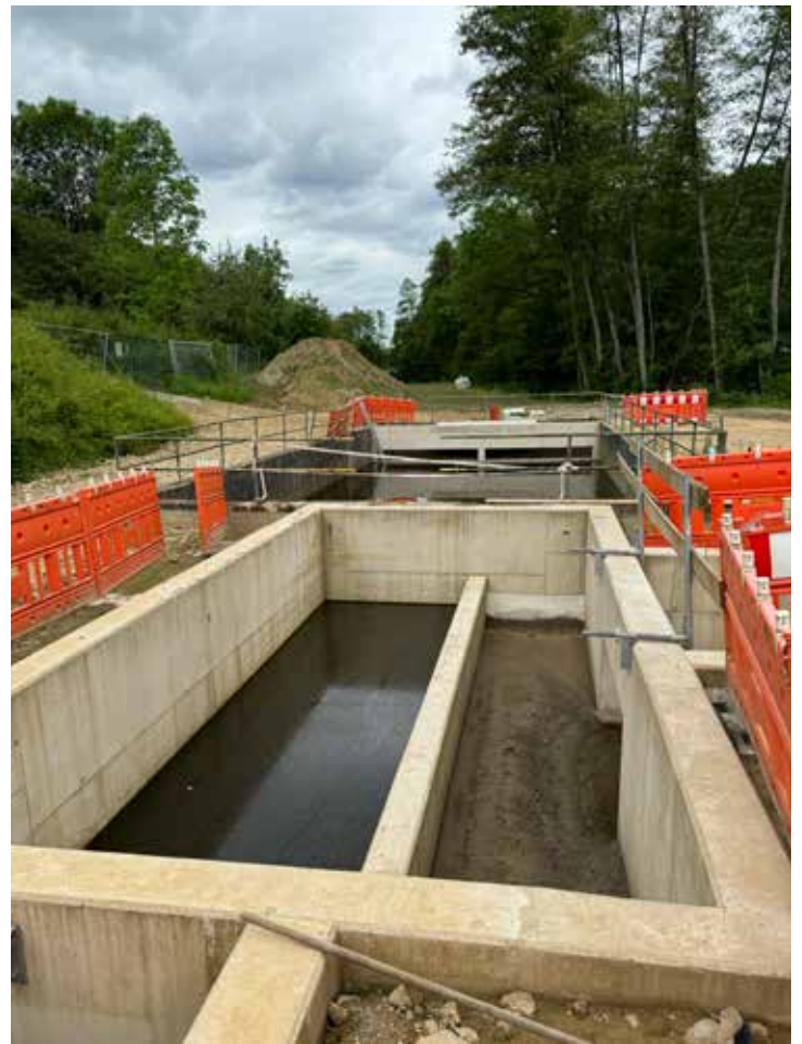
Teil des vergrößerten Regenrückhaltebeckens - Partie du bassin d'orage agrandi
