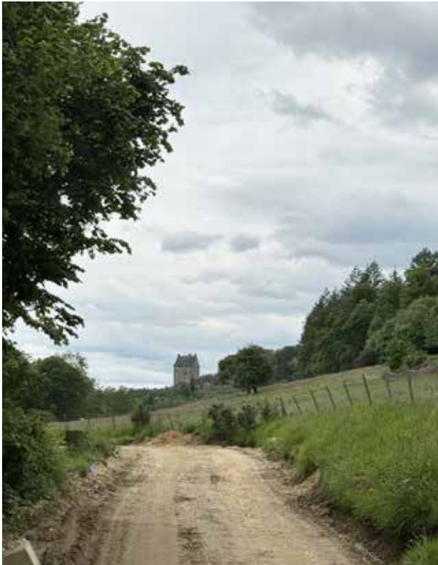
Aktueller Zustand des Fahrradwegs (Baustellenweg) - Etat actuel piste cyclable (piste de chantier)
