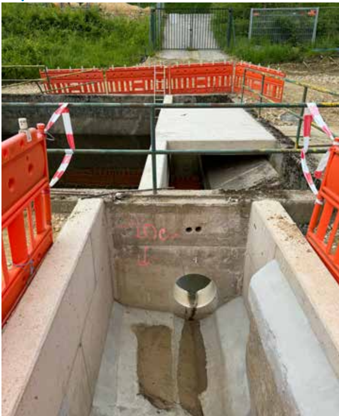
Teilansicht des umgebauten Rückhaltebeckens - Partie bassin d'orage transformé
