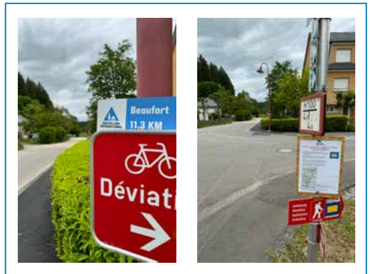
Beschilderung zum Umfahren der Bausstelle - Panneaux / signalisations en place pour con- tourner le chantier
