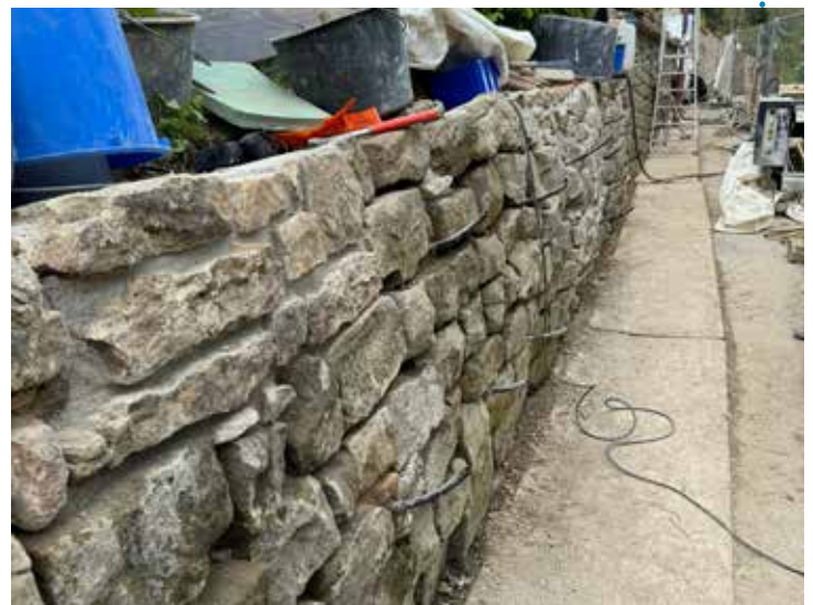
Stabilisierte Mauer vor dem Verfugen - Mur stabilisé avant rejointoiment
