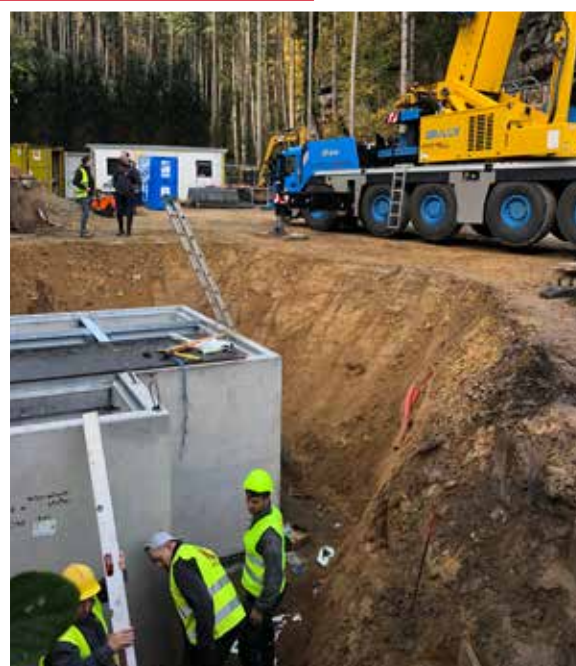
Setzen des Absetzschachtes Pose du regard de décantation
