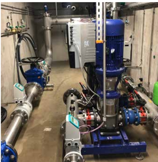
Hydrophore in der Schieberkammer auf "Guddelt" Hydrophore dans chambre à vannes « Guddelt »
