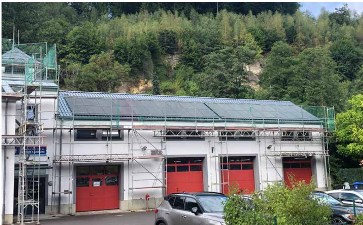
Aufbauphase - Installation der PV-Paneele auf der neuen Dachverkleidung
