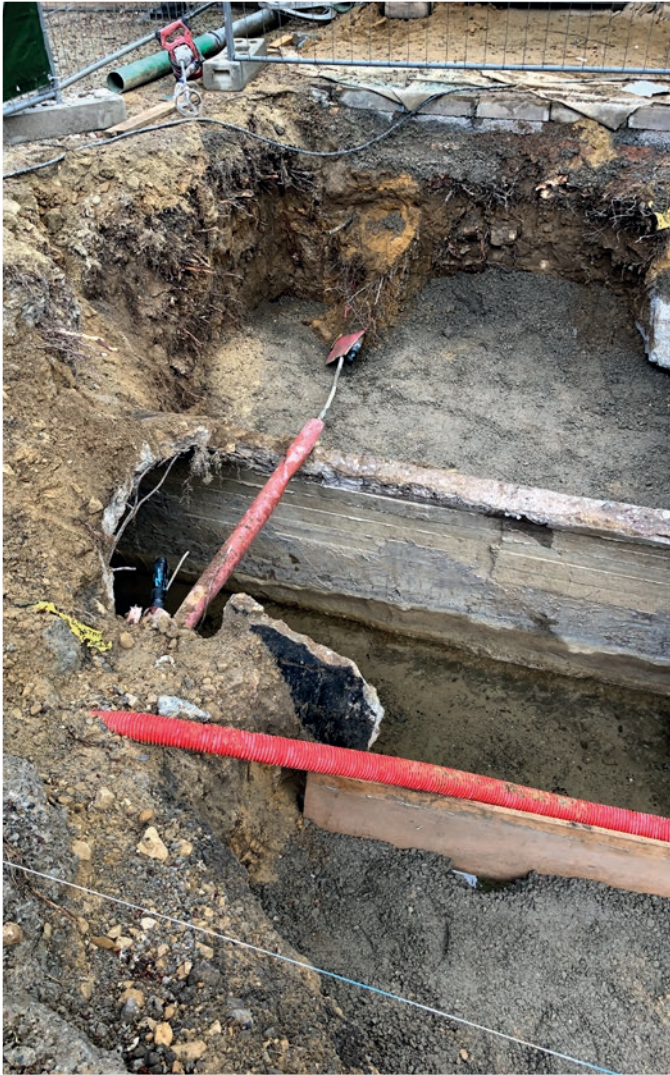
Bassin d'Orage place Bleech – déviation des réseaux en place Das Überlaufbecken auf der Place Bleech - Umleitung der bestehenden Versorgungsnetze
