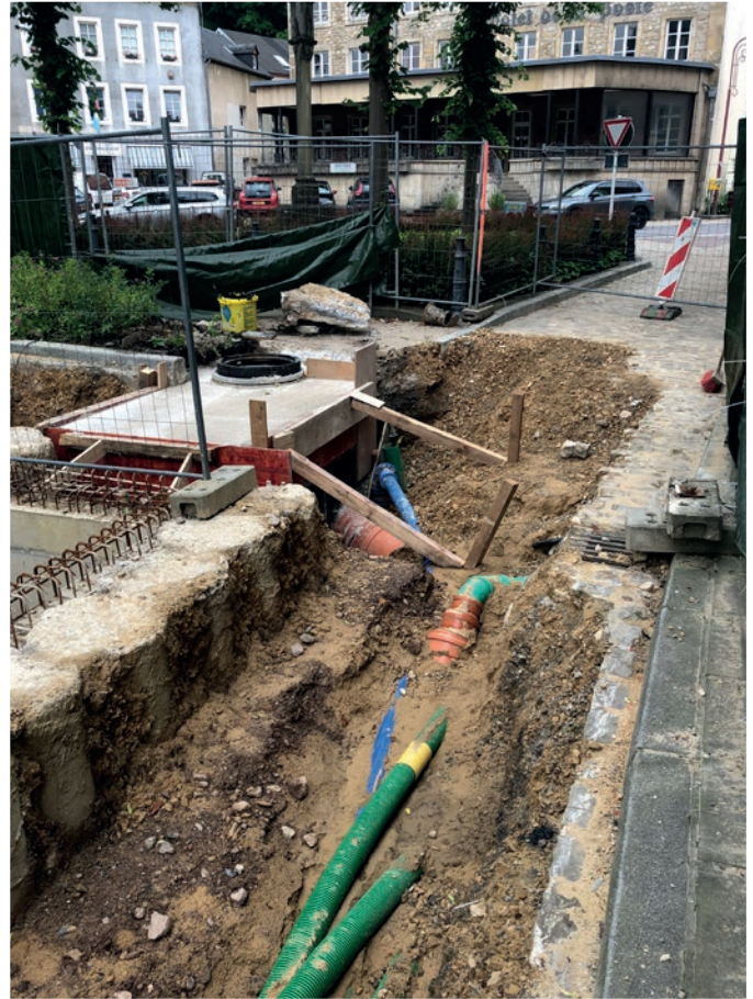
Bassin d'Orage place Bleech – déviation des réseaux en place Das Überlaufbecken auf der Place Bleech - Umleitung der bestehenden Versorgungsnetze
