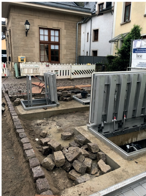
Bassin route de Mersch – Travaux de pavage avec trappes de visite ouvertes
