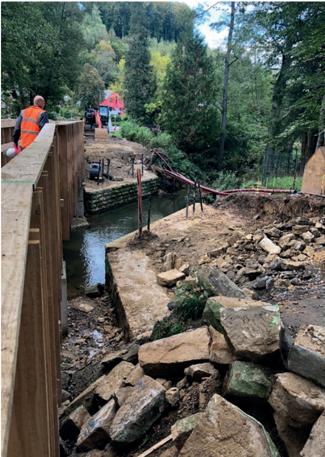
Pont «Um Daeich» démoli et micropieux pour futures fondations
