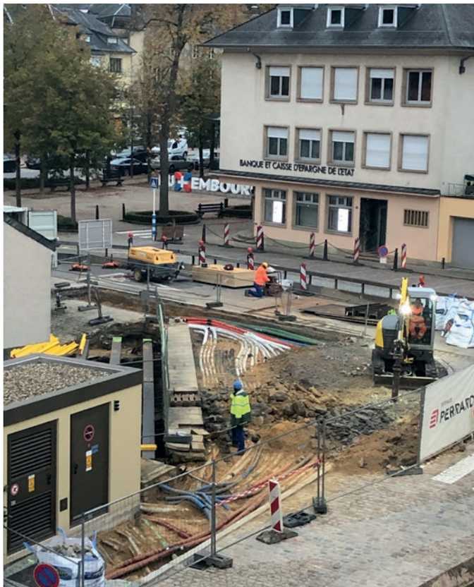
Travaux de déplacement des réseaux souterrains en cours Arbeiten zur Verlegung der unterirdischen Versorgungsnetze
