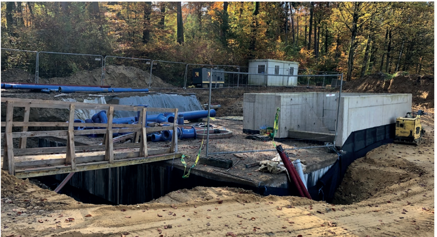
Gros-œuvre fermé avec travaux de tuyauterie en cours du regard de distribution «Seitert» Geschlossener Rohbau mit laufenden Rohrleitungsarbeiten des Verteilerschachtes " Seitert ".
