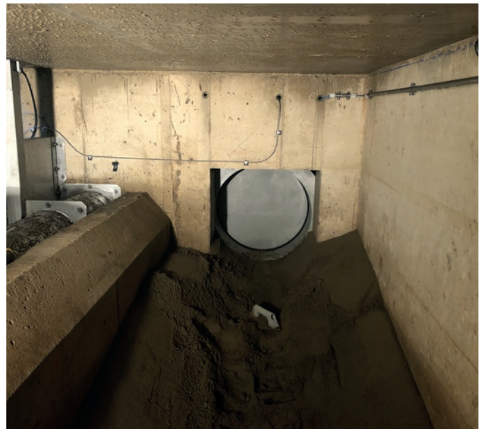
Bassin d'orage Place Bleech – Situation à l'intérieur – Cunette d'écoulement en exécution
