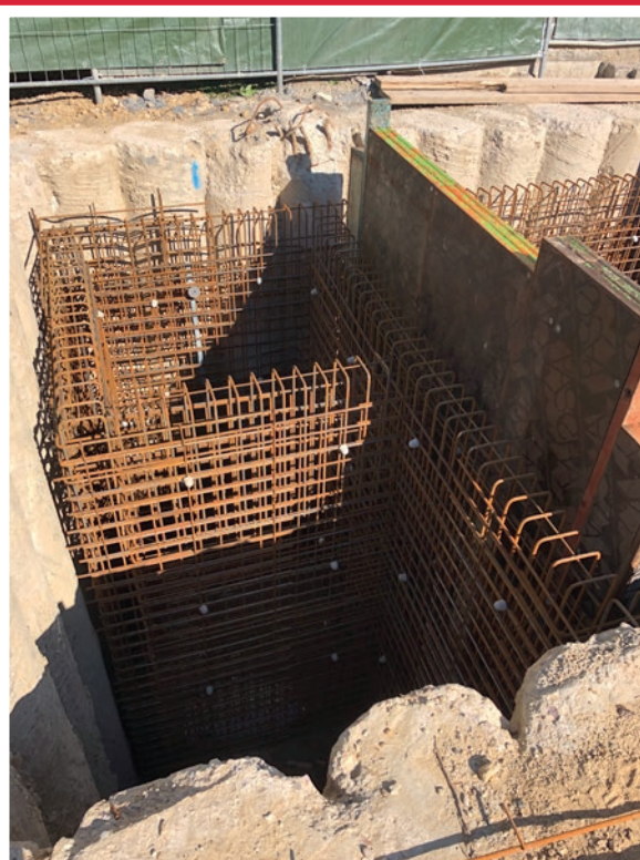
Bassin route de Mersch – Ferrailage des voiles Das Rückhaltebecken in der Merscherstrasse – Armierung des Schachts
