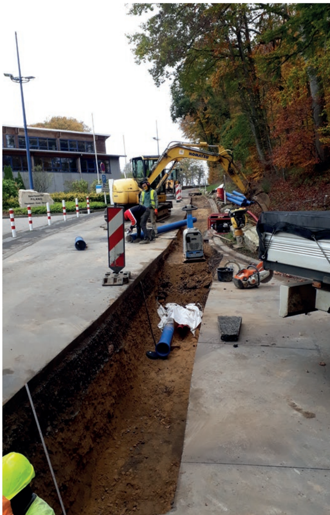
Gros-œuvre fermé avec travaux de tuyauterie en cours du regard de distribution «Seitert» Geschlossener Rohbau mit laufenden Rohrleitungsarbeiten des Verteilerschachtes " Seitert ".
