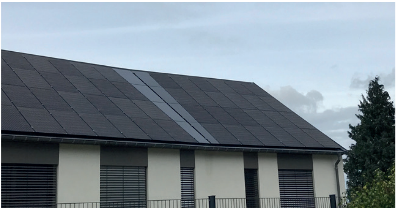
Exemple de panneaux appropriés pour l'emploi dans le « secteur sauvegardé » Beispiel für geeignete Paneele für den Einsatz im «geschützten Sektor»
