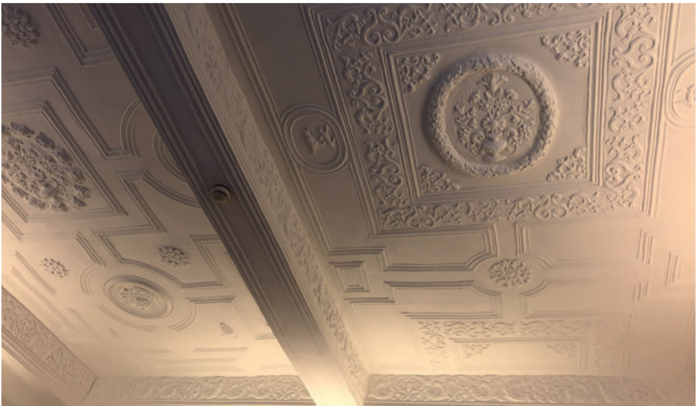
Sanierte und angestrichene Stuckdecke Plafond en stuc restauré et mis en peinture
