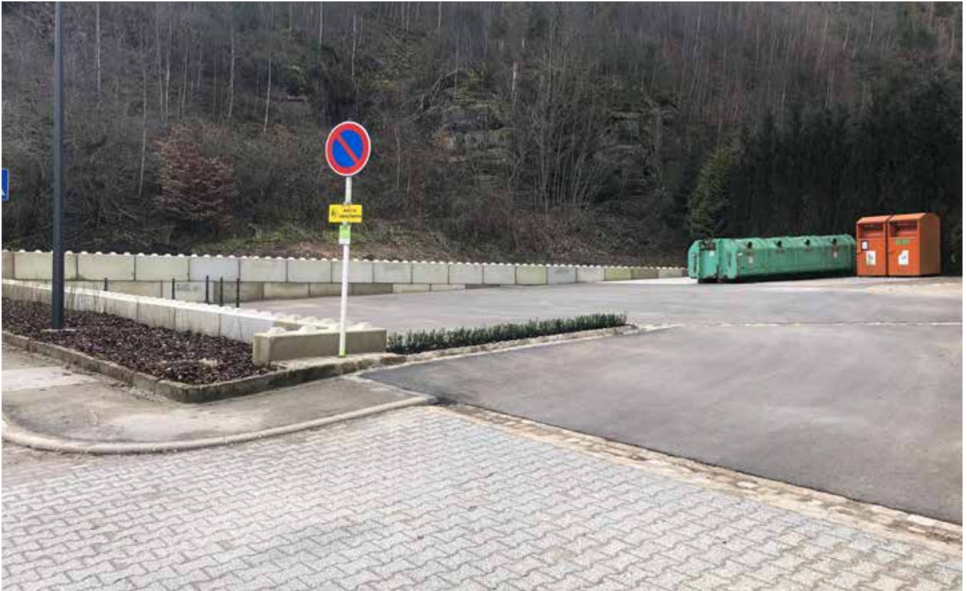
Containerpark nach den Hochwasserschutzmaßnahmen
