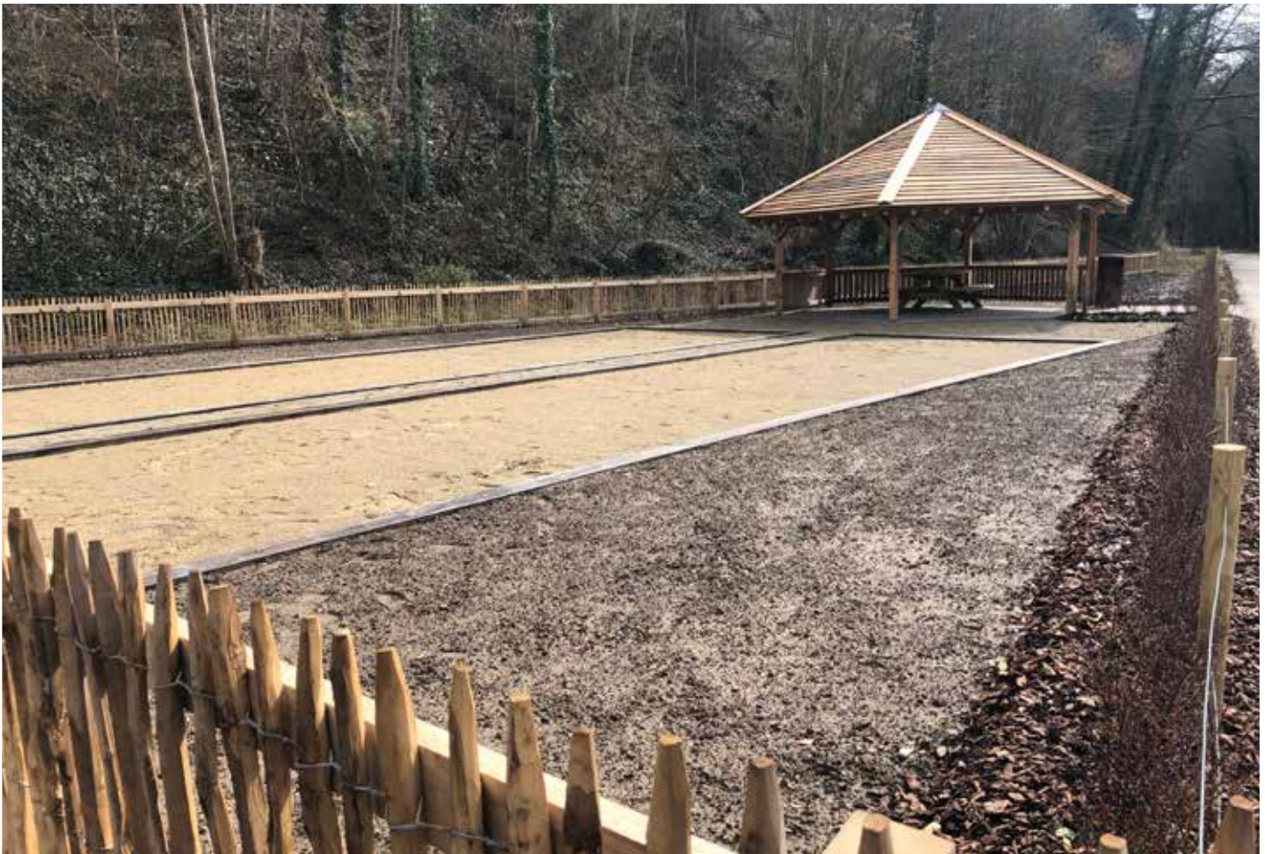
Fertige Gestaltung des Bouleplatzes Aménagement final aire de pétanque
