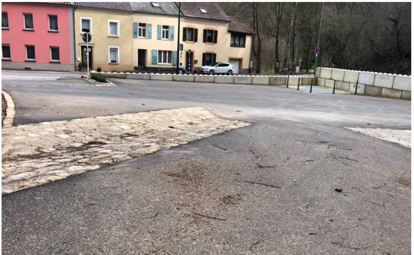
Rinne, um das Wasser in den Absetzschacht zu leiten
