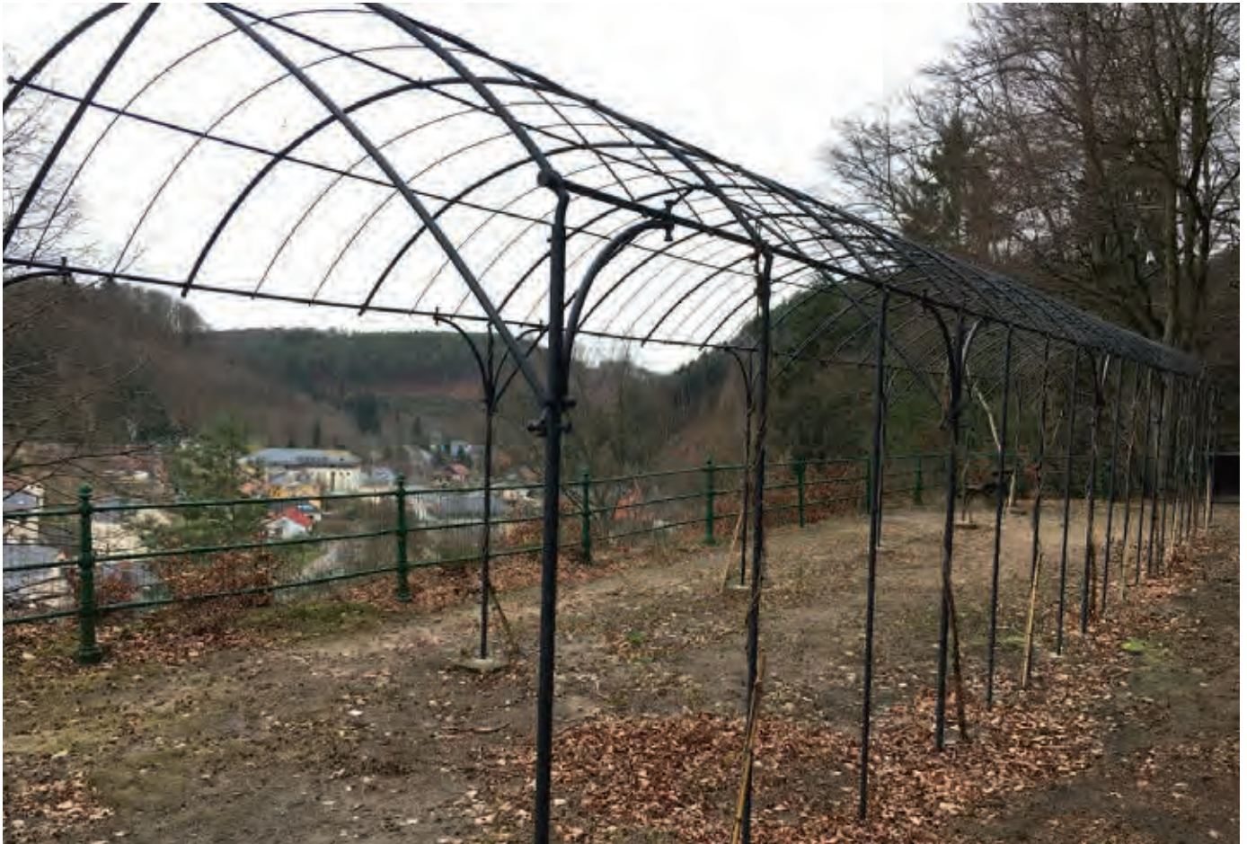
Pergola - Vue du point de vue « Himmelsbiërg »
