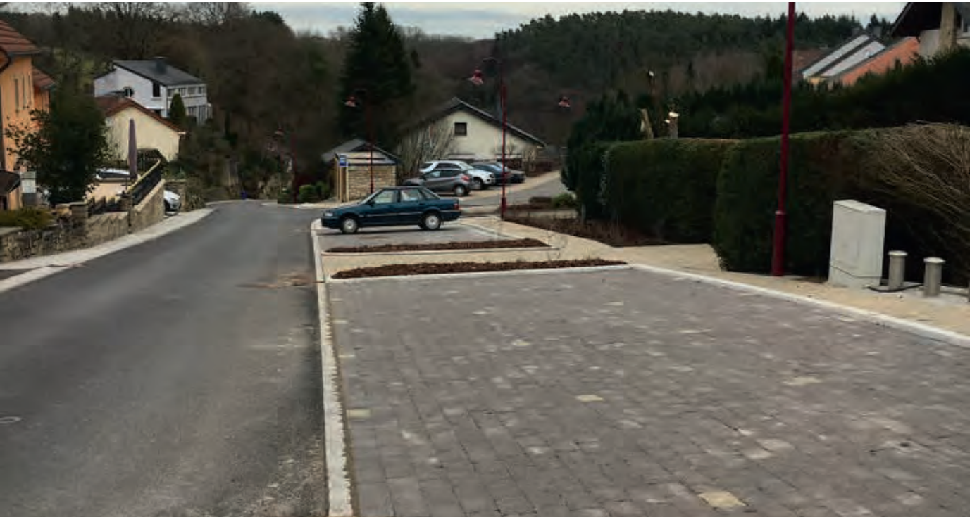
Les travaux au milieu de la montée d'Ernzen à l'endroit du nouveau parking aménagé Arbeiten auf halber Höhe der Montée d'Ernzen
