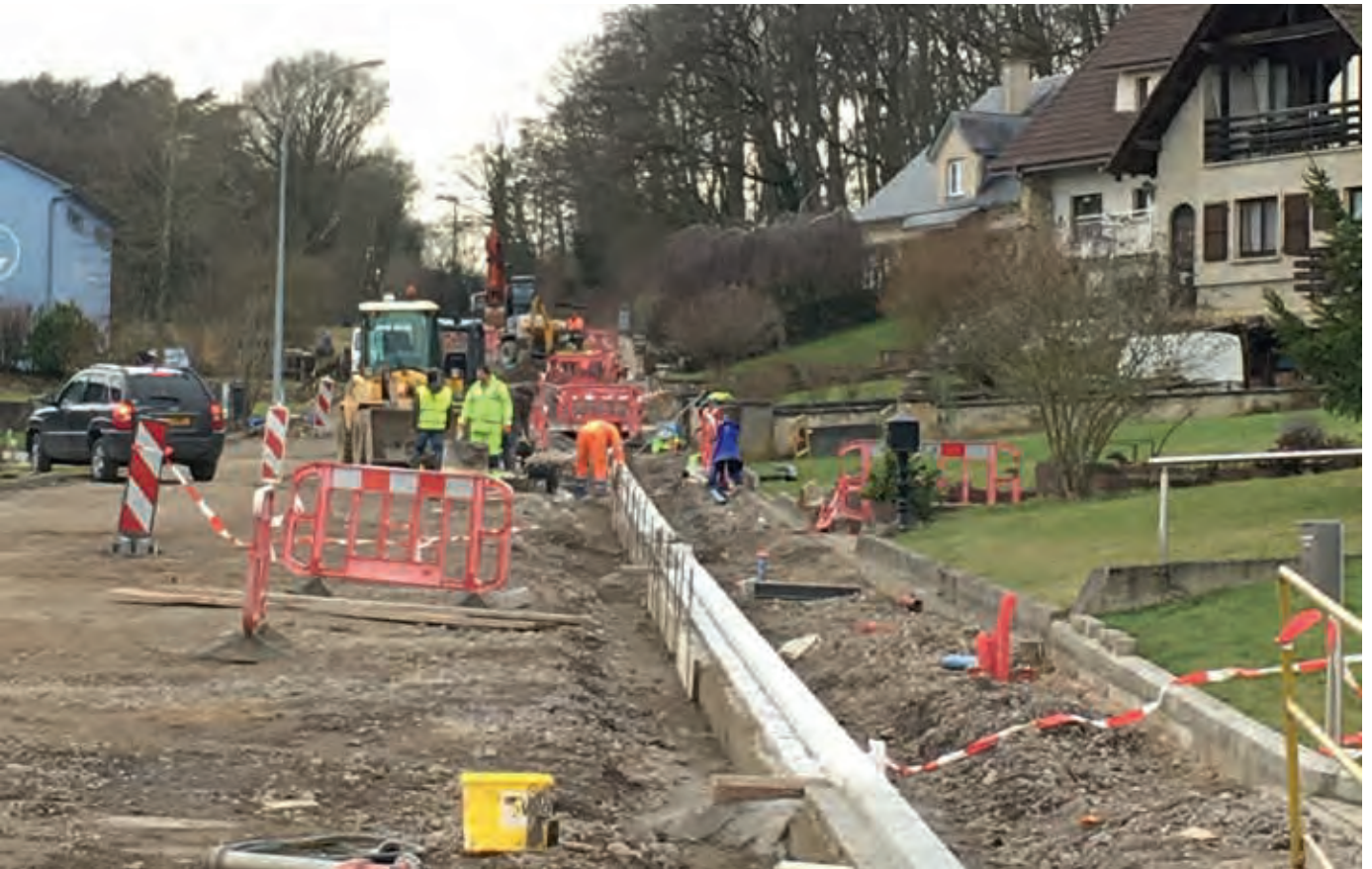
Travaux à la partie haute de la Montée d'Ernzen-Arbeiten im oberen Teil der Montée d'Ernzen
