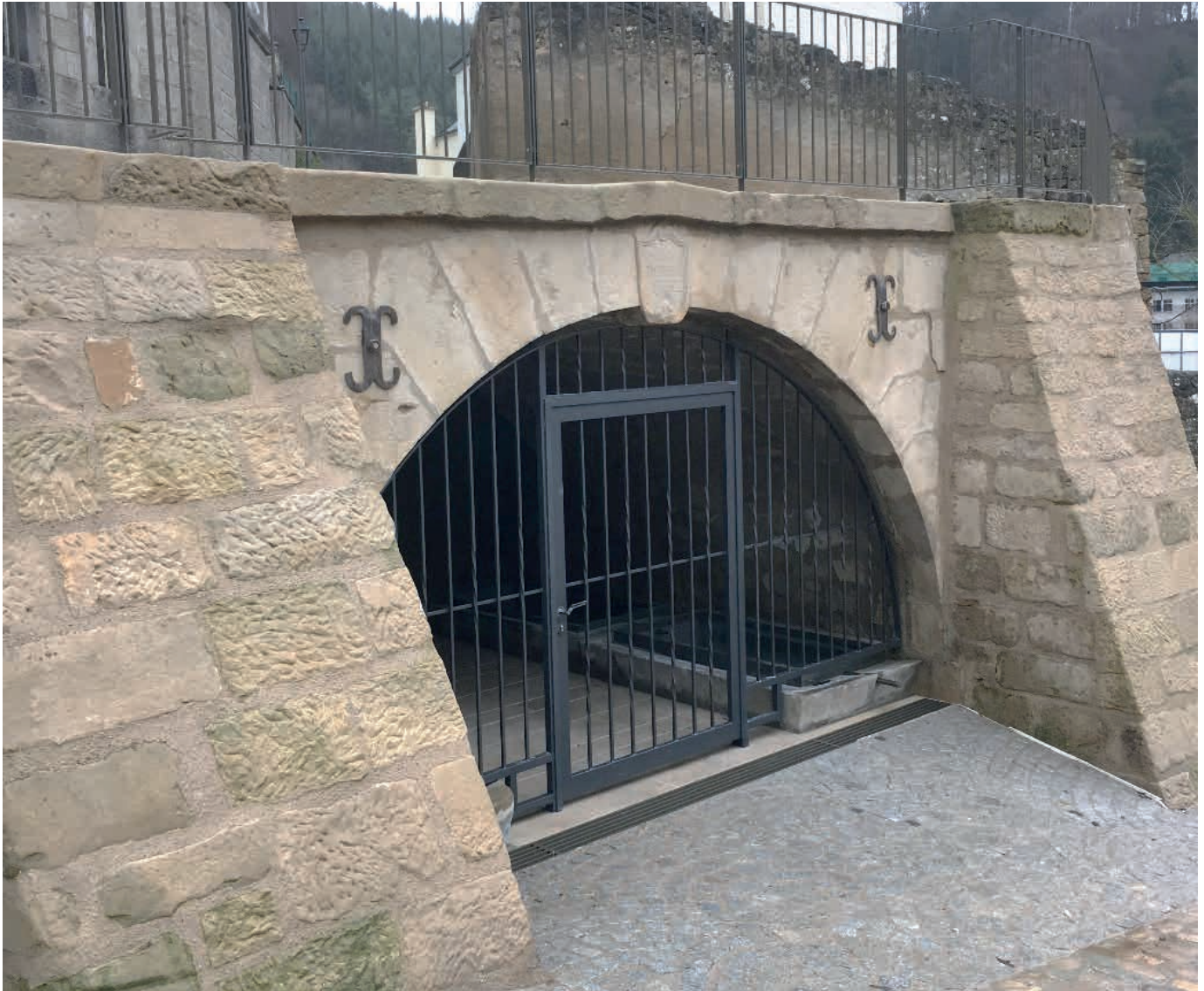
Instandsetzung des Alten Waschbrunnen
