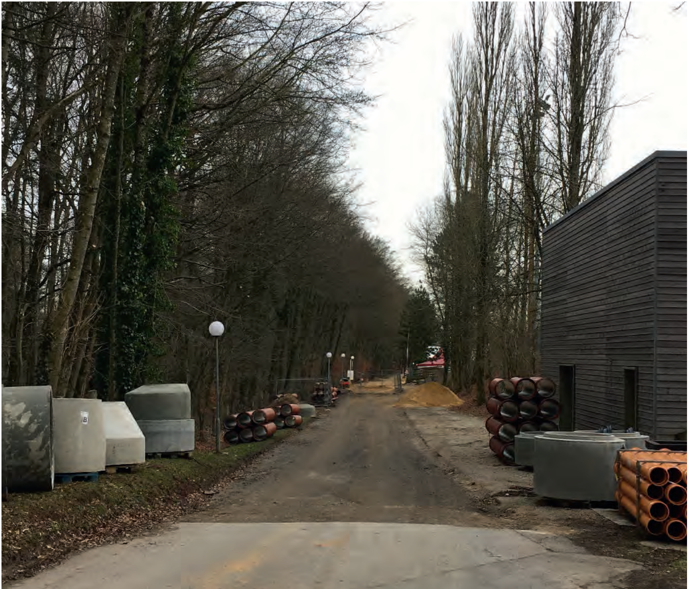
Chantier à hauteur de la buvette du terrain de football
