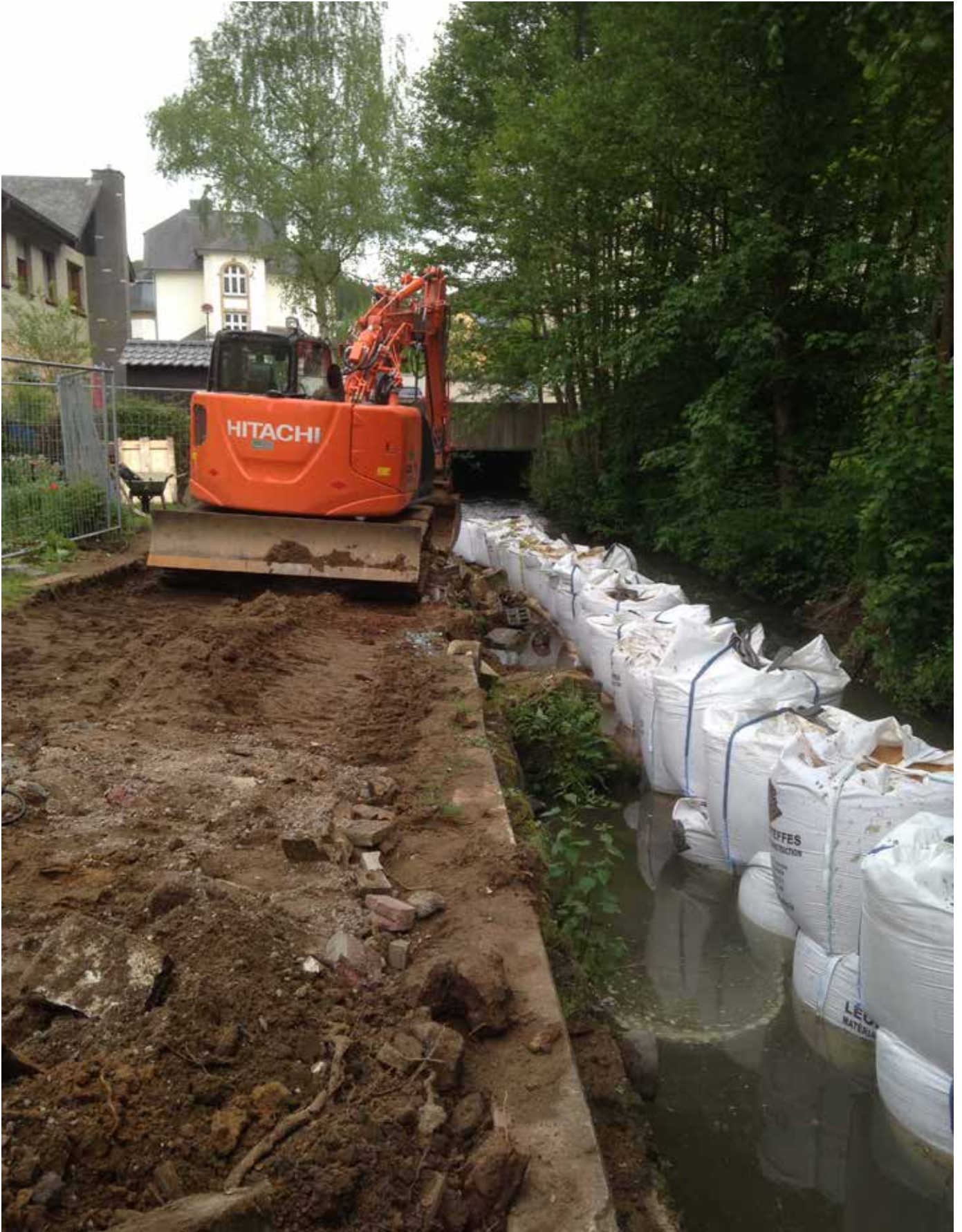
Neubau einer Mauer und Verstärkung der Böschung
