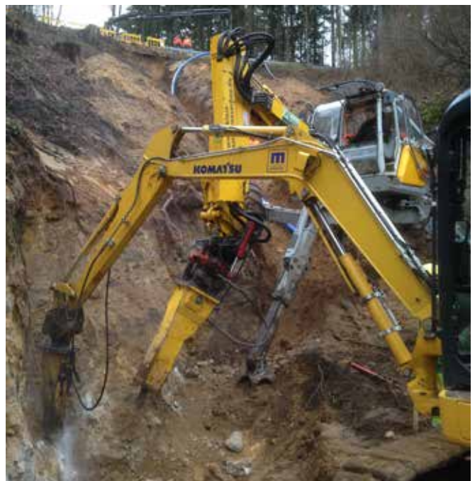
Einsatz des Spezialbaggers zu Herstellung des Grabens
