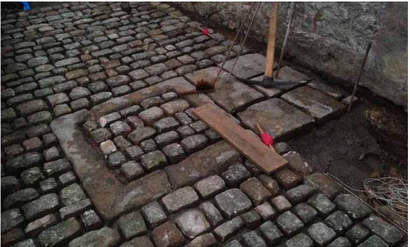
Pflasterarbeiten mit Erhalt bestehender Strukturen
