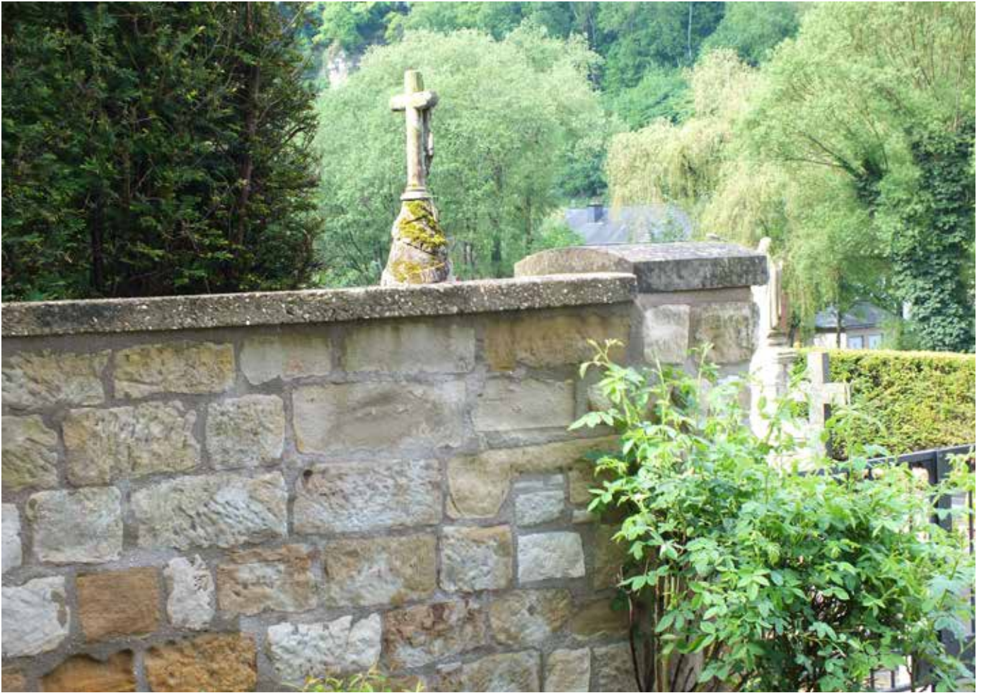
Stabilisierung und Neuverfugung eines Teils der Friedhofsmauern in Larochette
