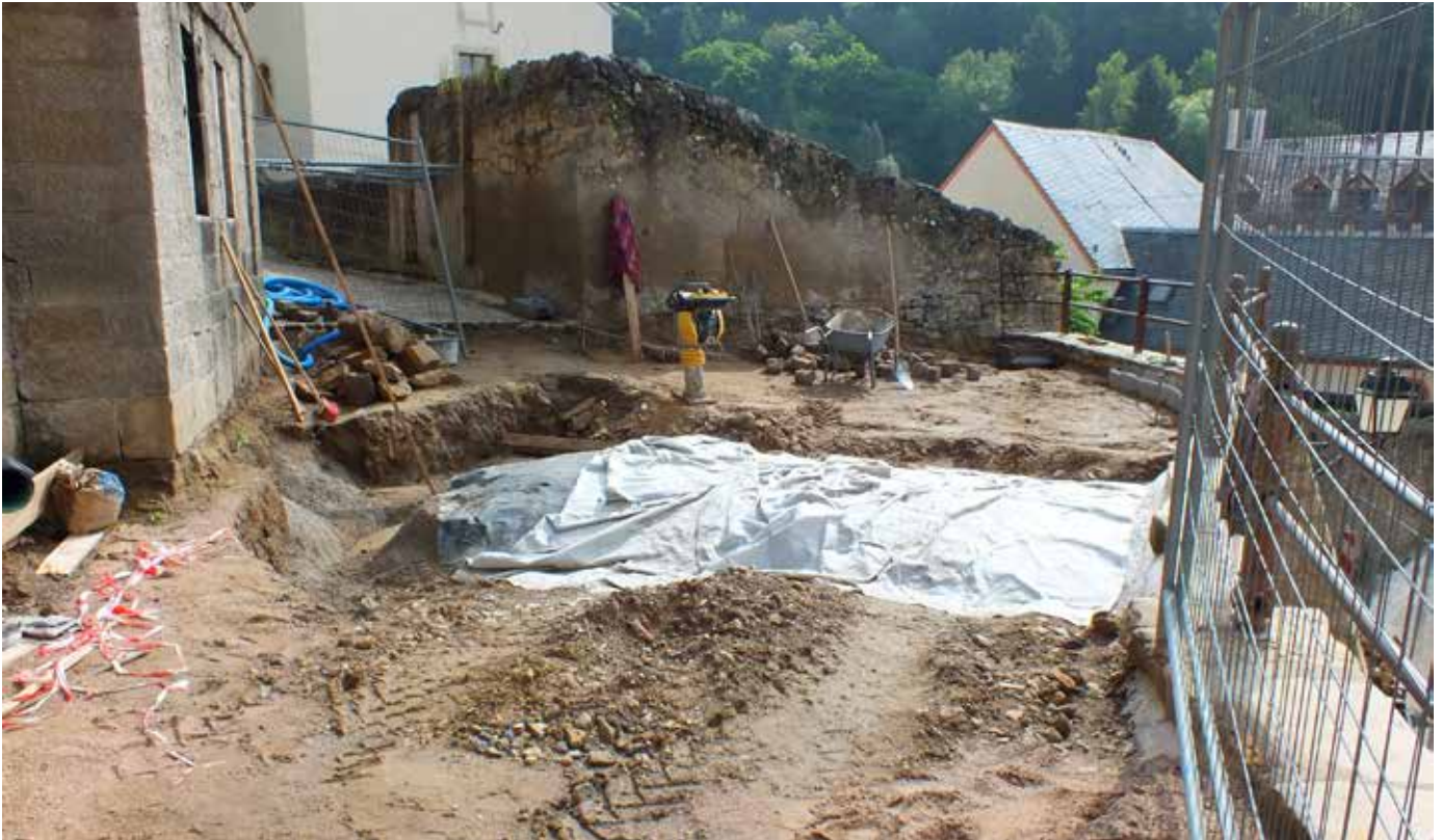
Oberseitige Abdichtung des Gewölbes
