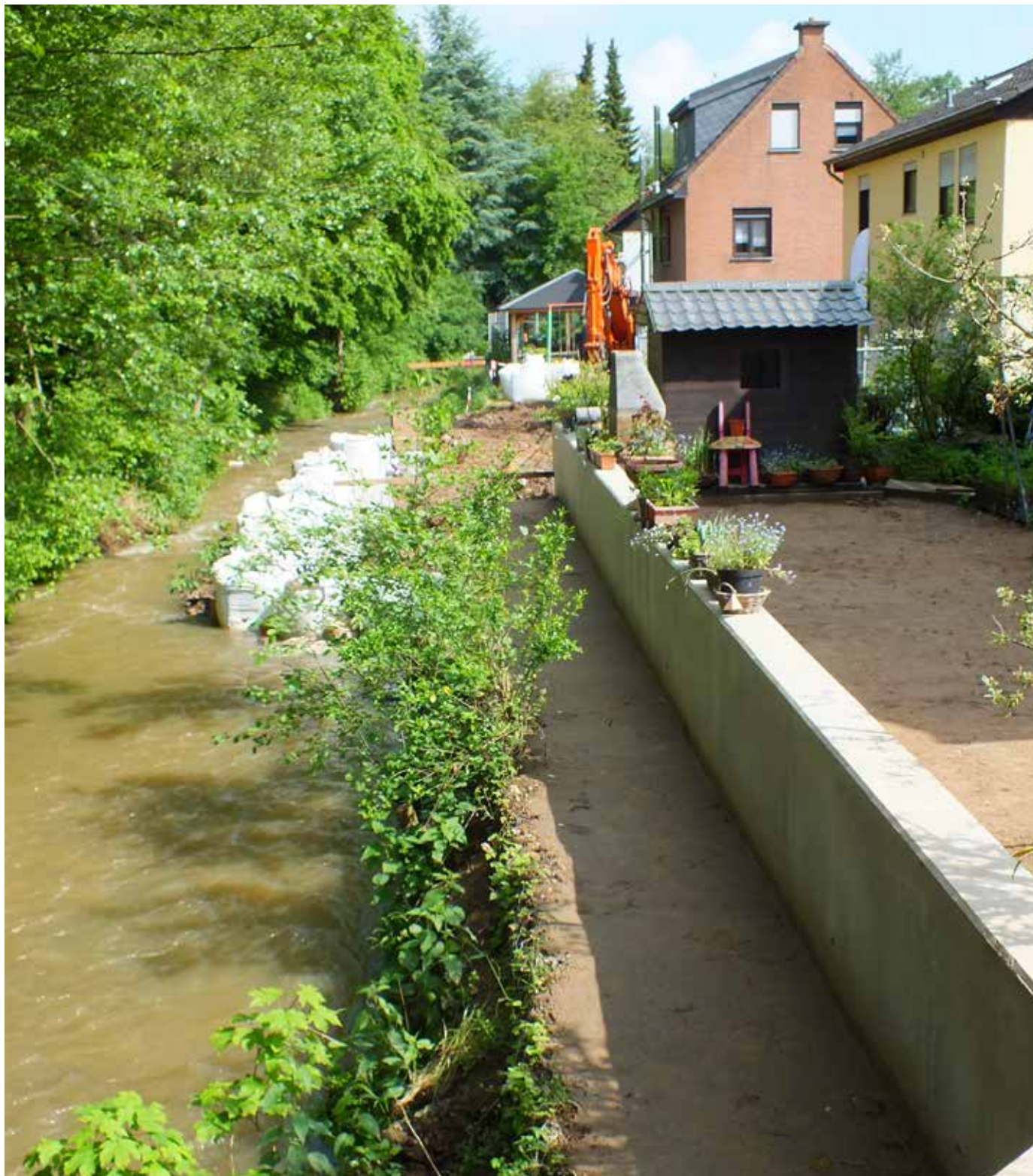
Erhöhung der bestehenden Uferböschung © Marc Diederich
