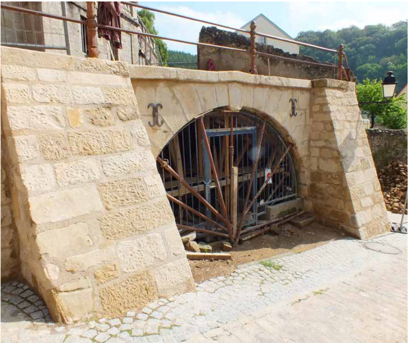
Gesichertes Gewölbe und saniertes Mauerwerk
