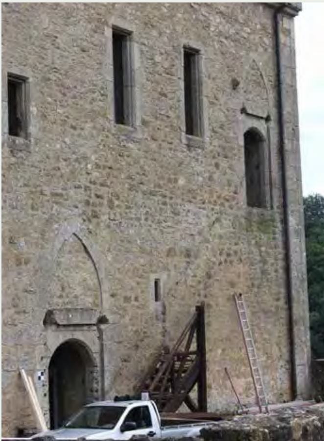
Durant le démontage (11 juin 2020)
