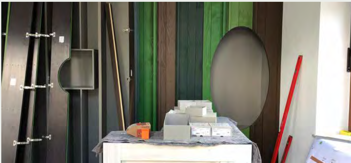
Installation et assemblage du mobilier - Installation und Montage des Mobiliars
