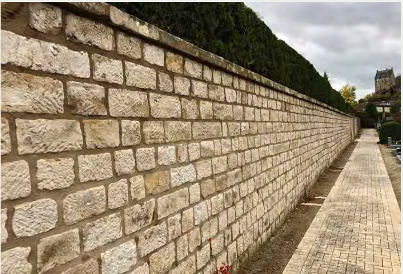
Mur assaini - sanierte Mauer
