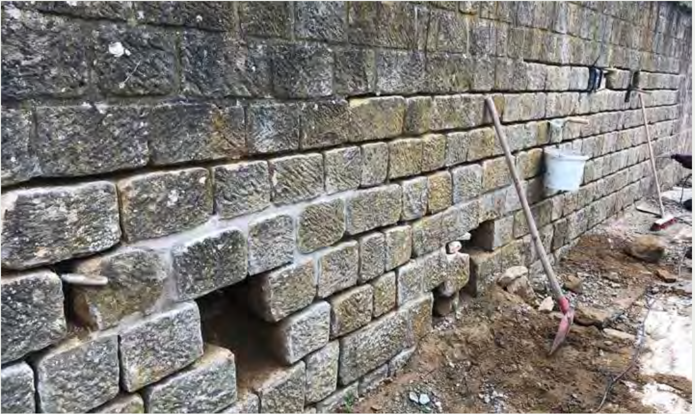
Travaux d'assainissement - Sanierungsarbeiten
