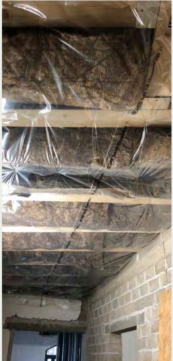
Ouvrages secs dans les nouveaux locaux sanitaires - Trockenbaumassnahmen in den neuen Sanitäräumen
