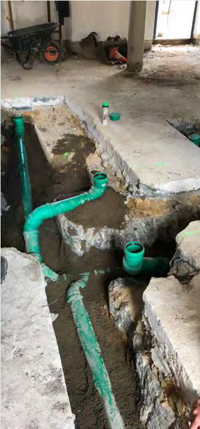
Renouvellement des réseaux enterrés (ici canalisation) - Erneuerung der unterirdischen Netze (hier die Kanalisation)
