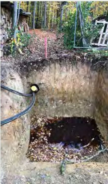
Conduites mises en œuvre par fonçage à proximité de la ferme Weydert - Durch Vortrieb verlegte Rohre in der Nähe des Weyderter Hofes
