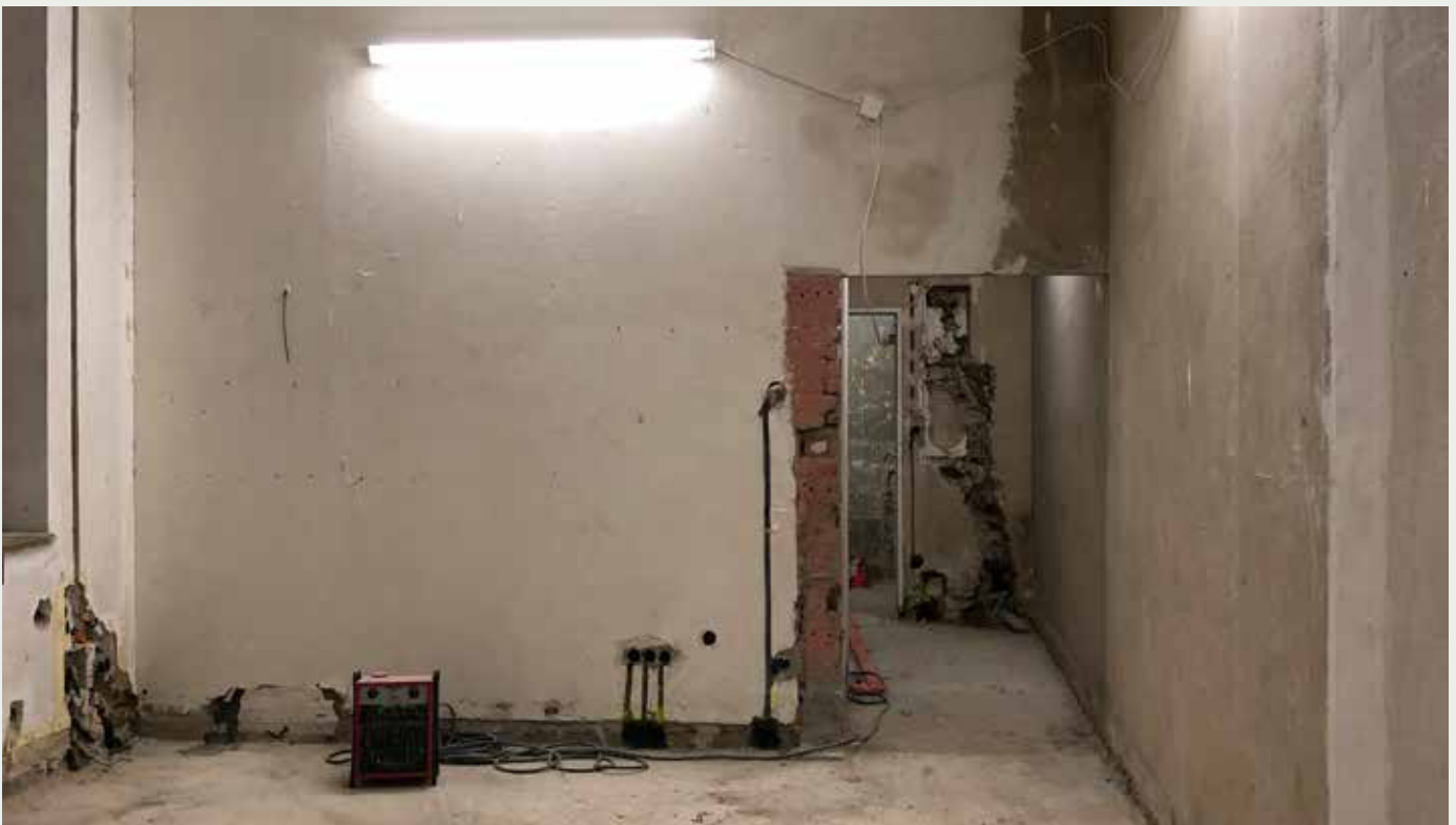
Le chantier - die Baustelle
