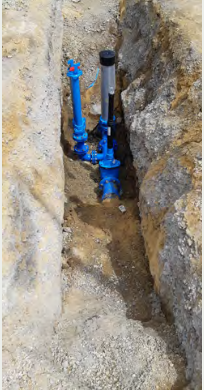
Nouvelle conduite d'eau potable (ventouse et croix de vannes) – Neue Trinkwasserleitung (Be- und Entlüftungsventil ; Schieberkruz)
