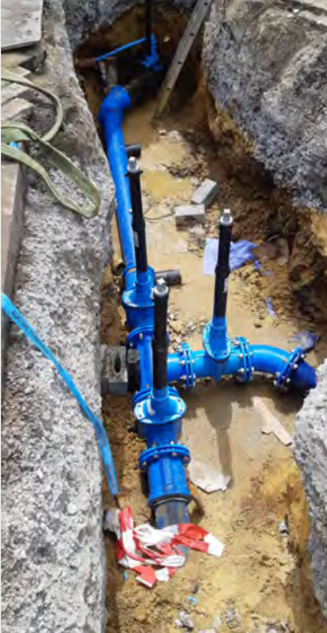
Nouvelle conduite d'eau potable (ventouse et croix de vannes) – Neue Trinkwasserleitung (Be- und Entlüftungsventil ; Schieberkruz)
