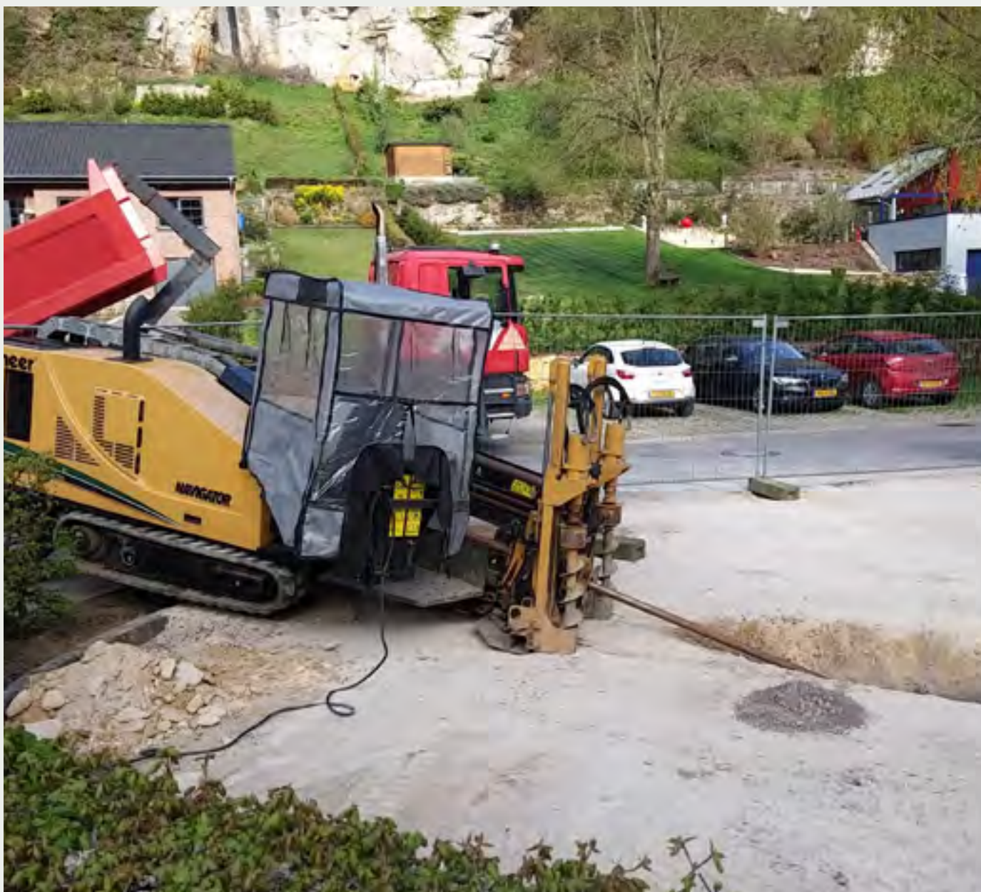
Machine de fonçage en action – Die Bohrmaschine im Einsatz
