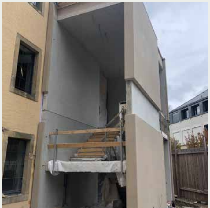
Nouvelle cage d'escalier et futur entrée principale – Neues Treppenhaus und zukünftiger Haupteingang
