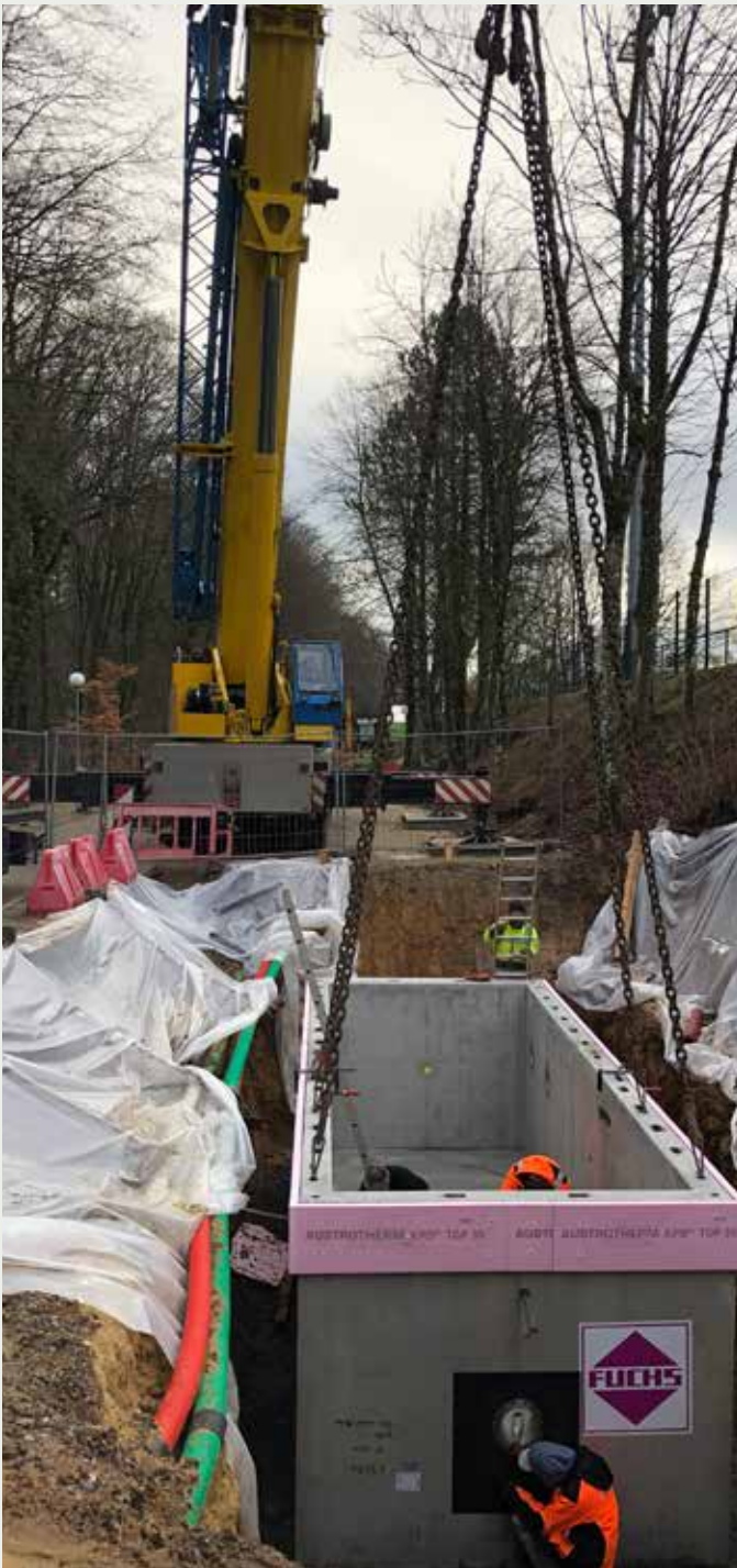
Pose du regard préfabriqué au plateau Birkelt. Einbau des Fertigteilschachtes auf dem Plateau Birkelt
