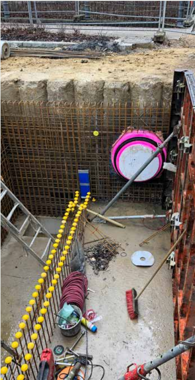
Bassin d'orage place Bleech – avant le bétonnage des voiles - Regenrückhaltebecken auf der Place Bleech - vor dem Betonieren der Wände
