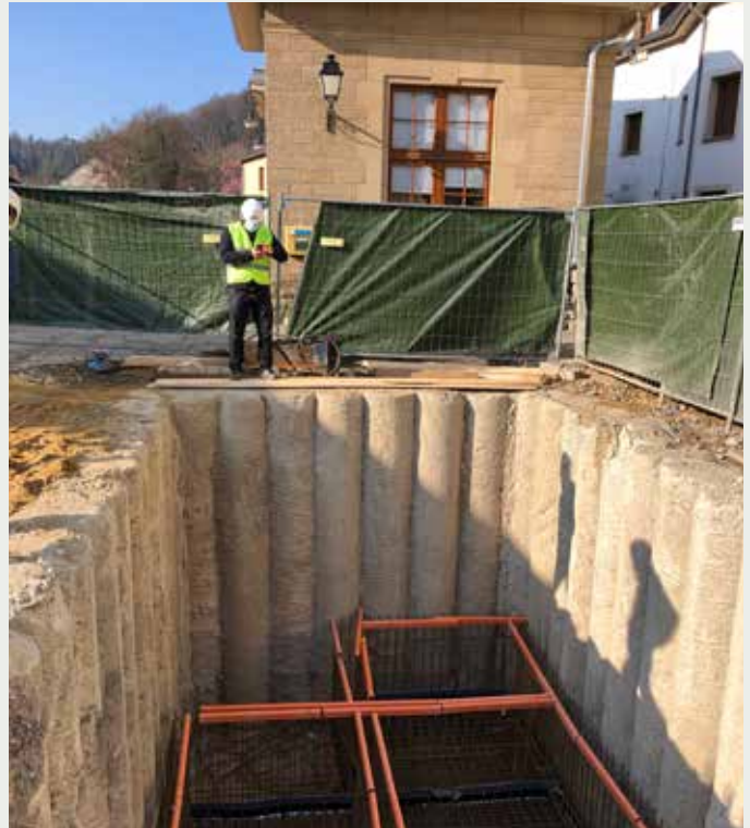
Bassin d'orage chemin J.A.-Zinnen - Fouille avec radier ferrailé - Regenrückhaltebecken im J.A. Zinnen-Weg - Ausschachtung mit armerter Sohle
