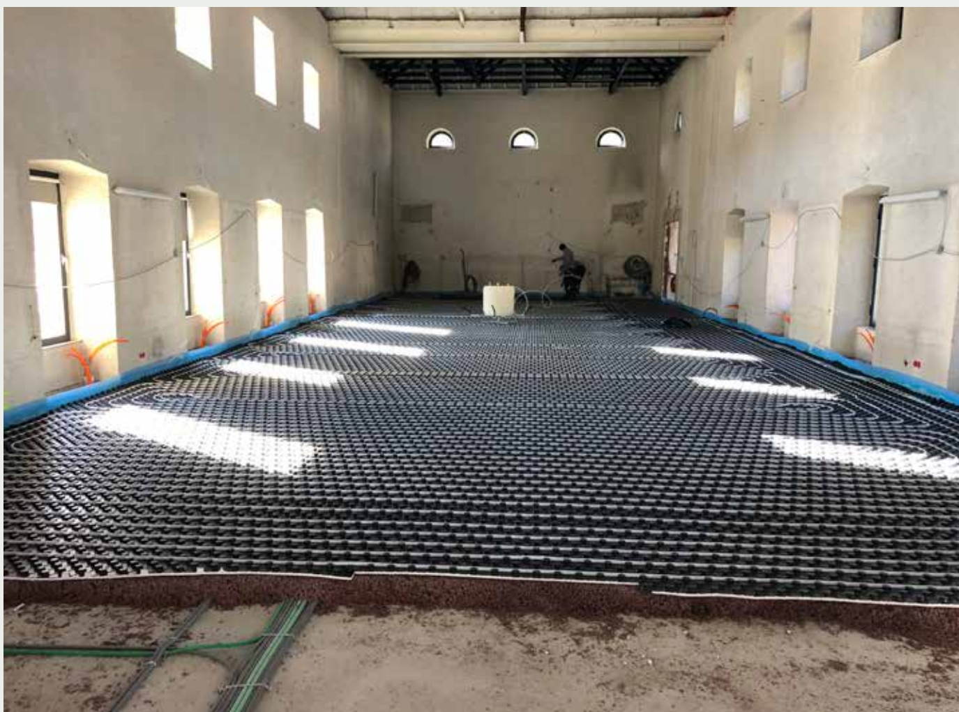
Pose du chauffage de sol au premier étage – Installation einer Fußbodenheizung in der ersten Etage
