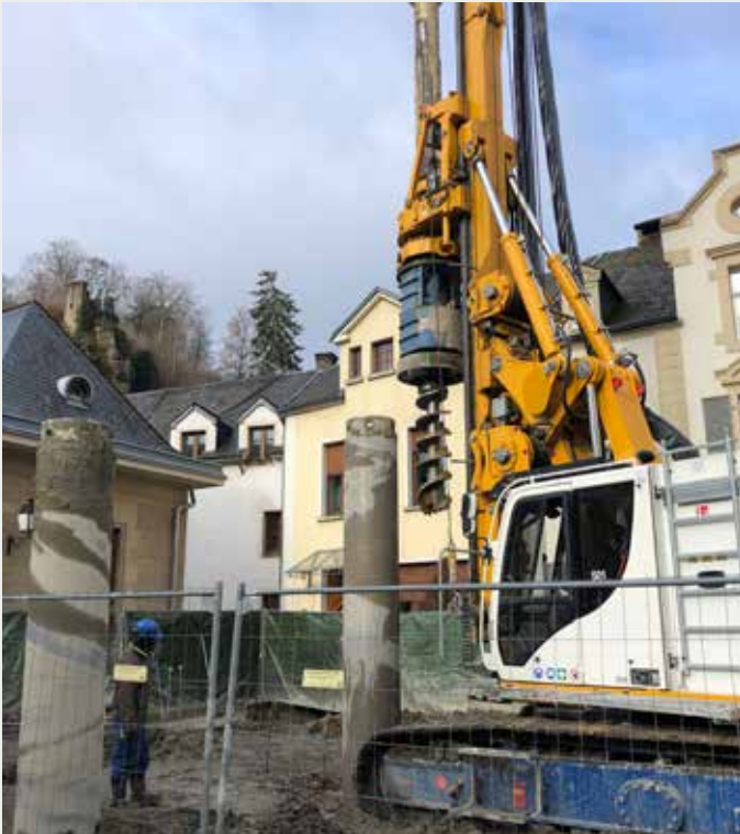
Foreuse pour pieux sécants en action - Die Säulenbohrmaschine im Einsatz
