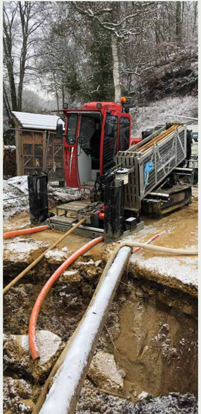
Foreuse en action pour le fonçage des conduites de la « Bëschcèche » vers le plateau Birkelt – Die Bohrmaschine in Betrieb für das Verlegen der Rohre von der "Bëschcèche" zum Plateau Birkelt
