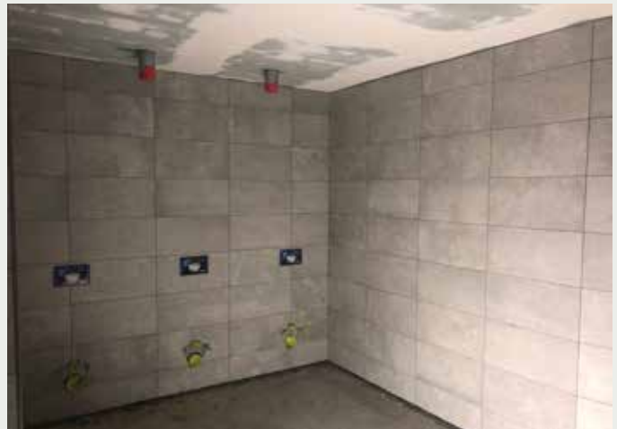
Espace sanitaire au rez-de-chaussée – Sanitärbereich im Erdgeschoss
