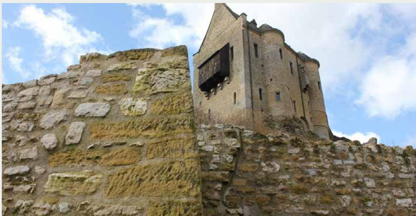
Photos : enceinte médiévale en cours de restauration
